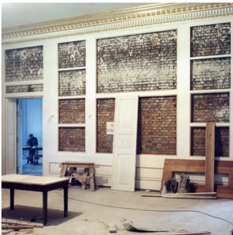
6. Montowanie boazerii w Pokoju Canaletta, Zamek Królewski w Warszawie, 1976 (nr 80.1)
