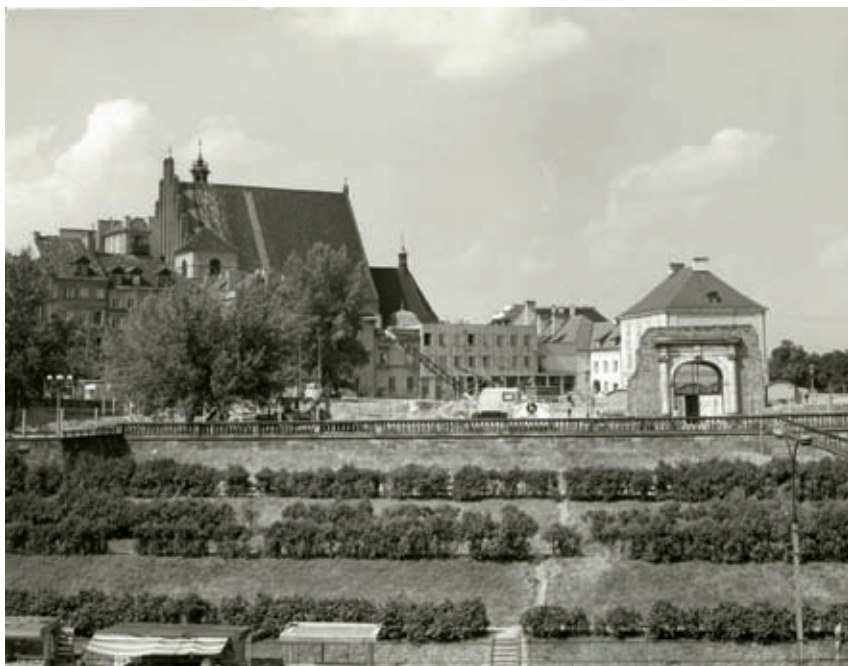
7. Porządkowanie terenu Zamku Królewskiego w Warszawie przed rozpoczęciem prac budowlanych, 1971 (nr 80.4)
