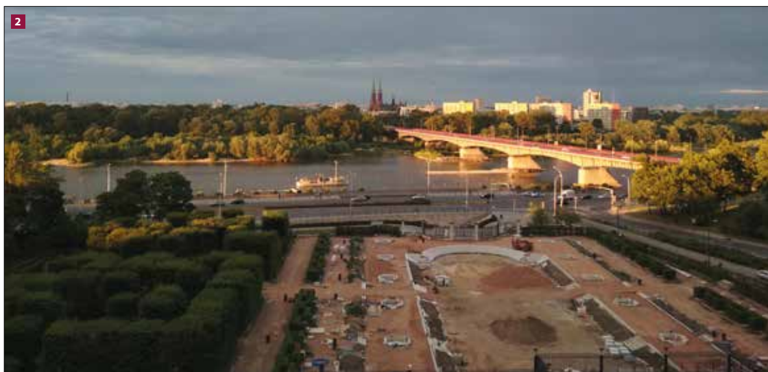
1 2 Prace budowlane przy rekonstrukcji Ogrodu Dolnego
